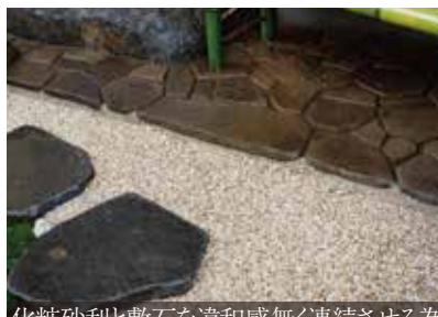
化粧砂利と敷石を違和感無く連続させる為以前施工の敷石基礎は改めて洗い出し
