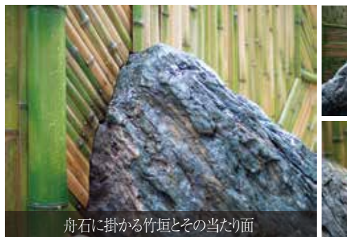
縦・横・斜め45度(左右)の四方向に貼り込む
