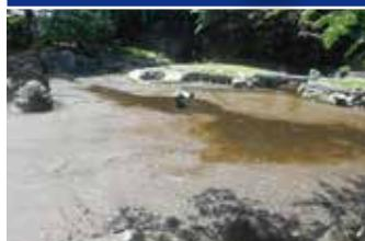
池の水を抜いて、底が見えている状態です。一見して多量の汚泥が堆積しているのが分かります。
